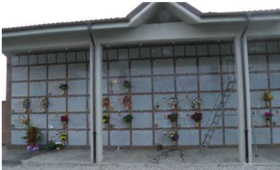
Cellette ossario su loculi comunali (II ampliamento)
