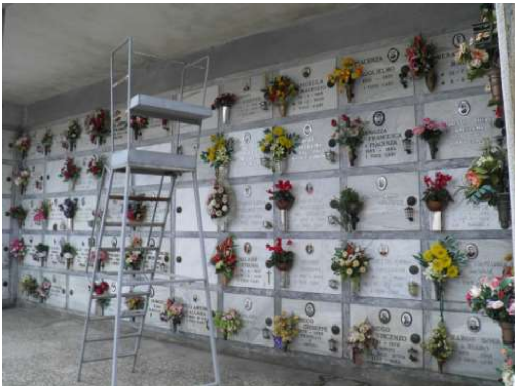
Loculi comunali lato nord (l ampliamento)
