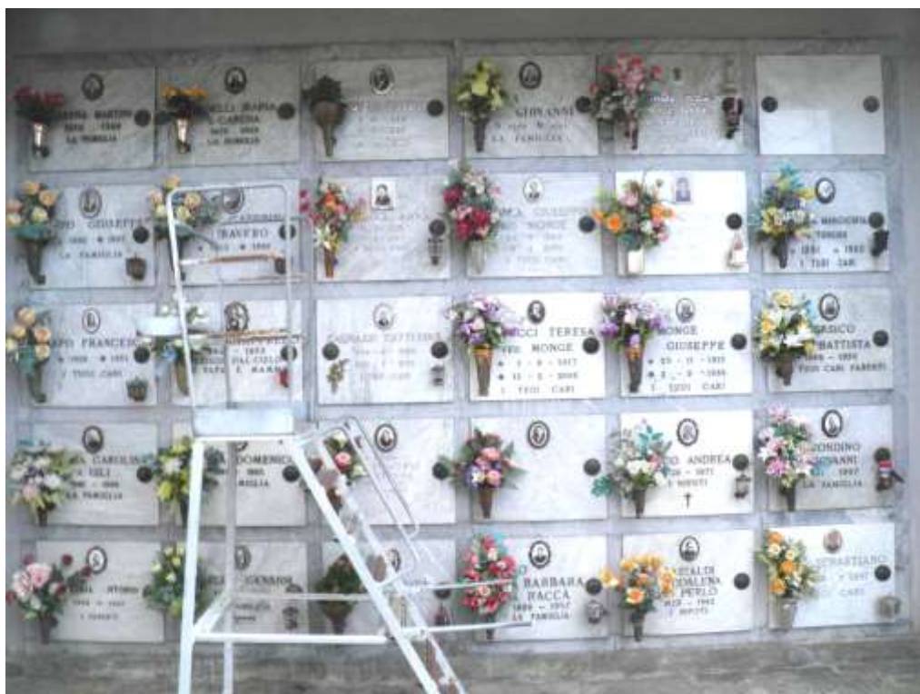
Loculi comunali lato ovest (I ampliamento)
