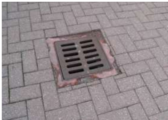
Caditoie di raccolta acque meteoriche
