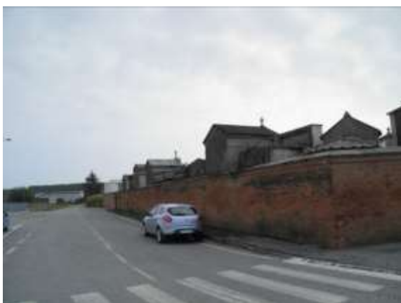
Muro Nord del Cimitero
