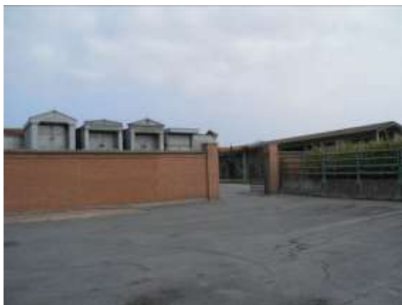
Muro sud del Cimitero
