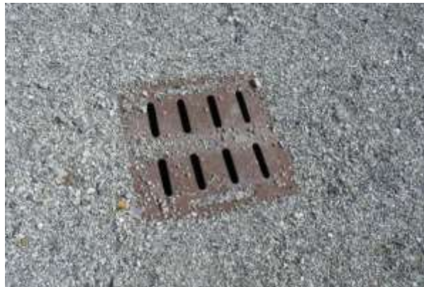
Caditoie di raccolta acque meteoriche
