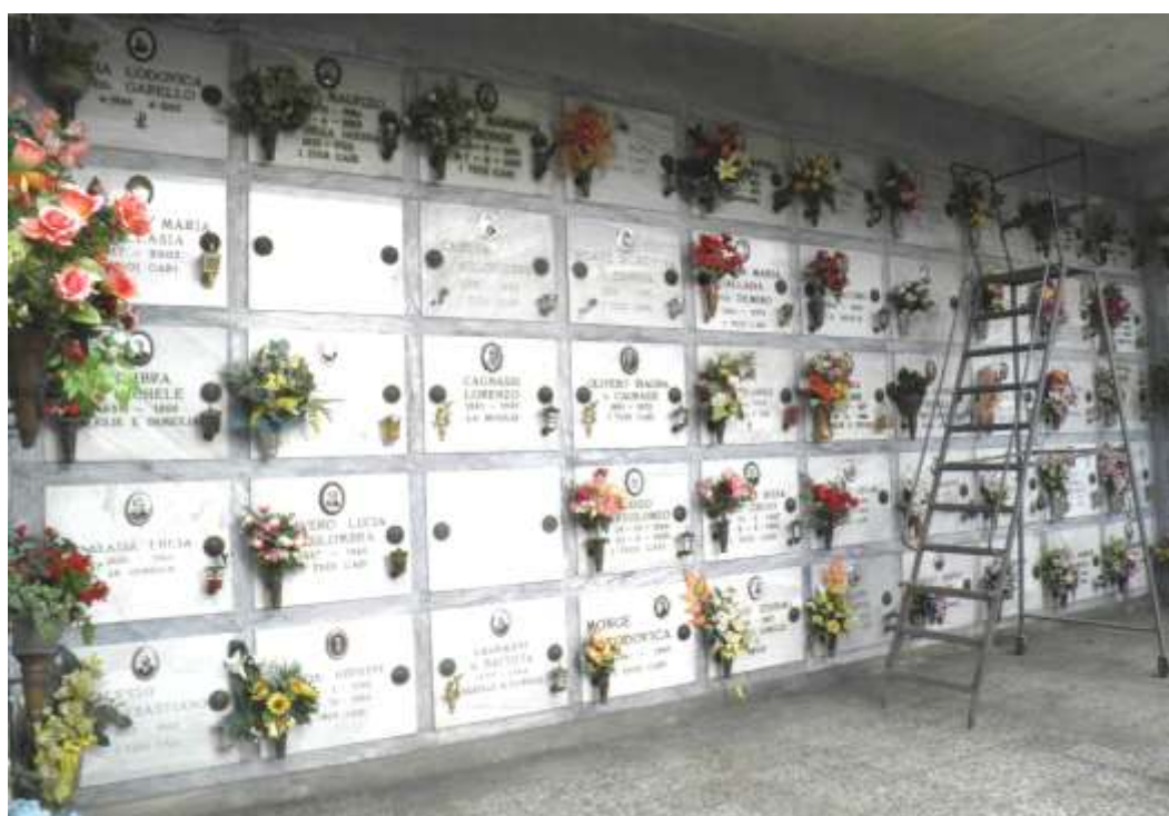
Loculi comunali lato sud (I ampliamento)
