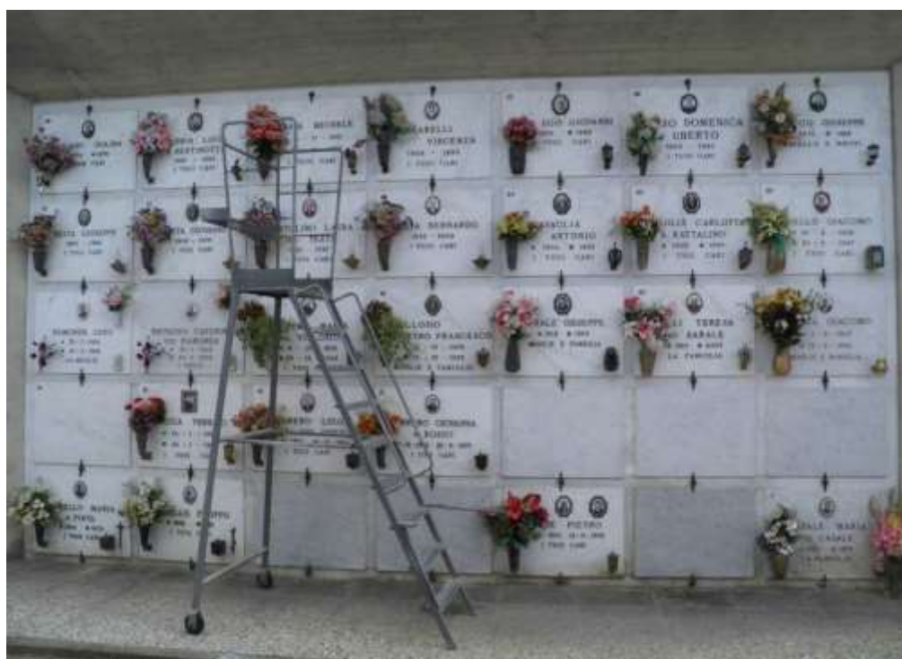
Loculi comunali est – lato ovest (nucleo cimiteriale storico)
