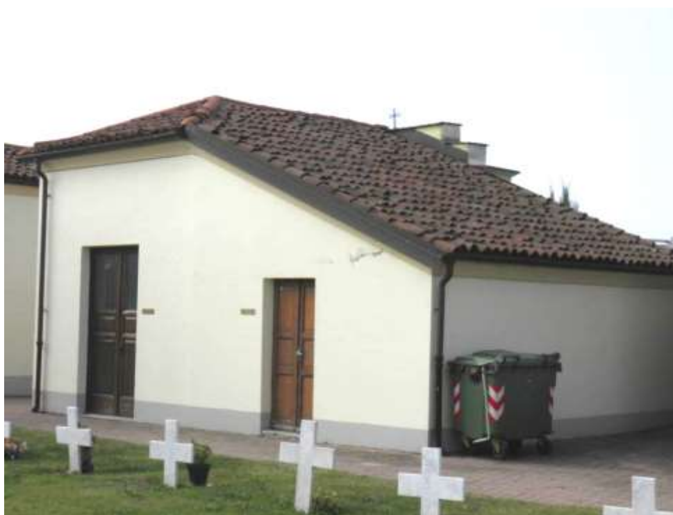
Ossario comune a sinistra dell'ingresso
