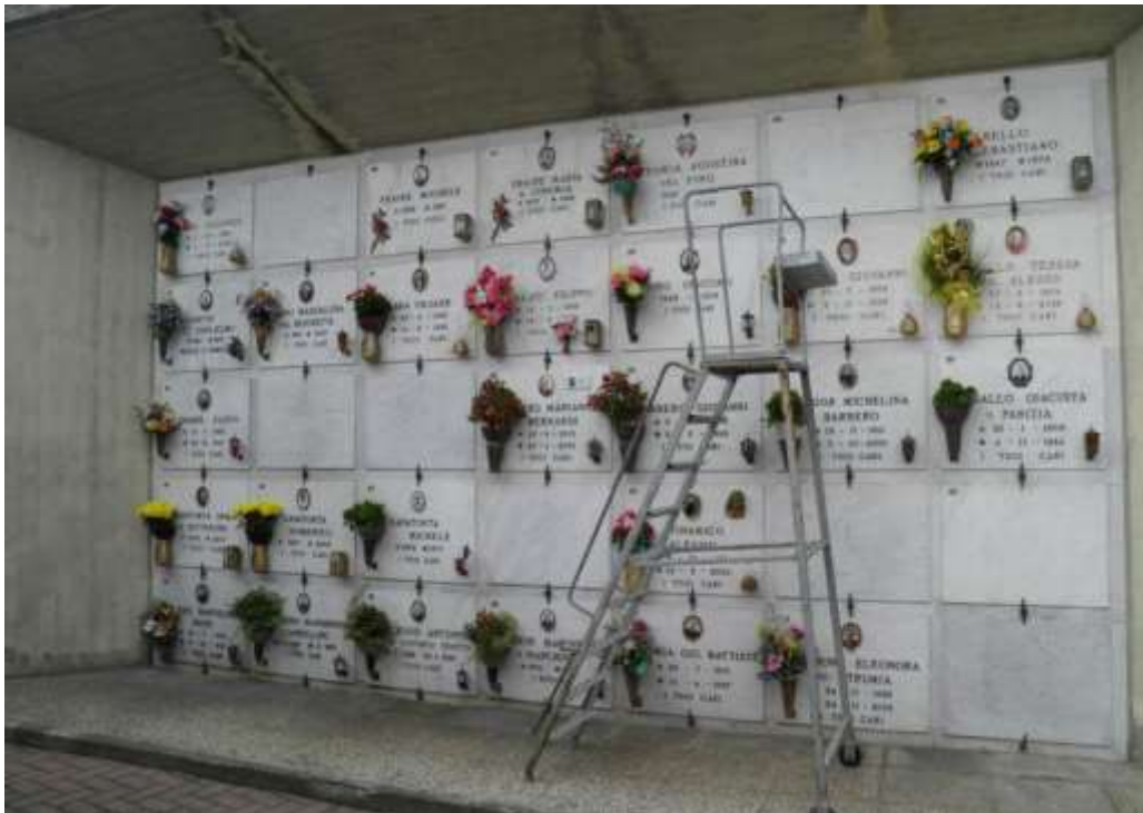
Loculi comunali est – lato est (nucleo cimiteriale storico)
